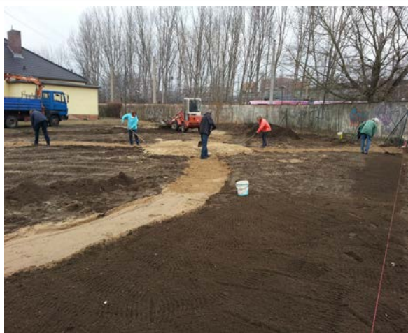
Abschieben des Oberbodens und Wegebau, Januar 2015
