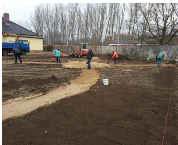
Abschieben des Oberbodens, Wegebau, Januar 2015
